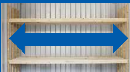
1 コンテナの凹凸に合わせ支柱を設置
