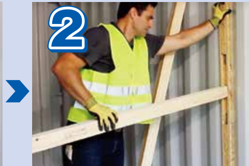
2 支柱に掘られた溝に横棒を挿し込む
