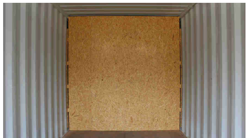
Bild 17 (Quelle: Fairfix) OSB-Trennwand geschlossen
