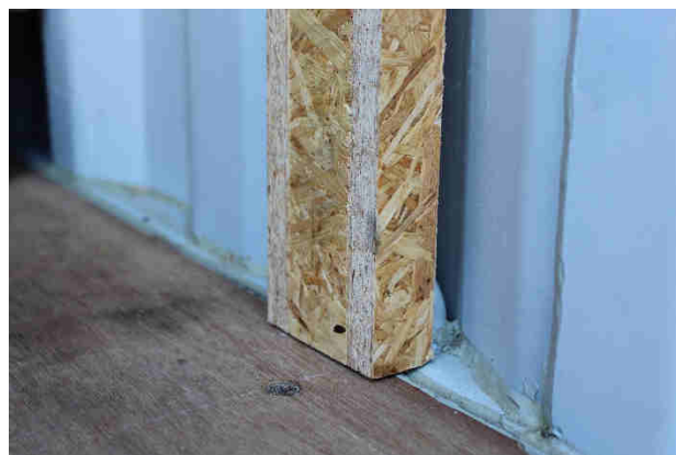
Bild 4 (Quelle; Fairfix): Stütze vor Lashpunkt – Laderaumverlust
